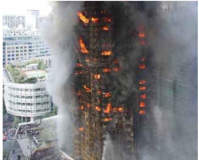
La gravité de l'incendie de Shanghai est attribuable en partie à l'isolant en mousse d'uréthane qui a contribué à la propagation des flammes et de la fumée.
